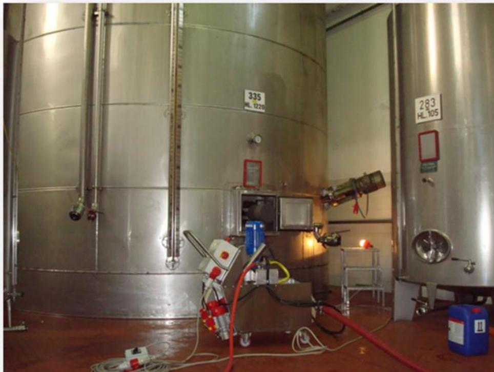
L'impianto mobile di lavaggio "La Semplice" è una soluzione **innovativa, sicura e molto efficace** per pulizia dell'interno di serbatoi e vasche di qualsiasi tipologia e materiale (**vetroresina, cemento, metallo...**), nata per il settore enologico, ma adatta anche per altri contenitori del settore alimentare.
